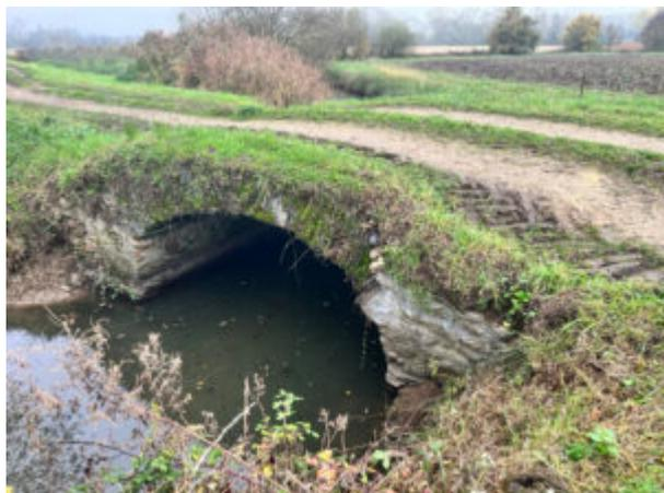
En raison d'un affaissement constaté sur l'un des côtés du pont situé sur le chemin rural reliant les secteurs de Bousseline à La Hamelle, la ville a procédé à la fermeture en urgence de cet ouvrage. En effet, les inspections récentes ont révélé un risque accru d'effondrement. Afin de garantir la sécurité de tous, ce passage est interdit à tous les usagers (véhicules, tracteurs, deux-roues et piétons compris) jusqu'à nouvel ordre.
