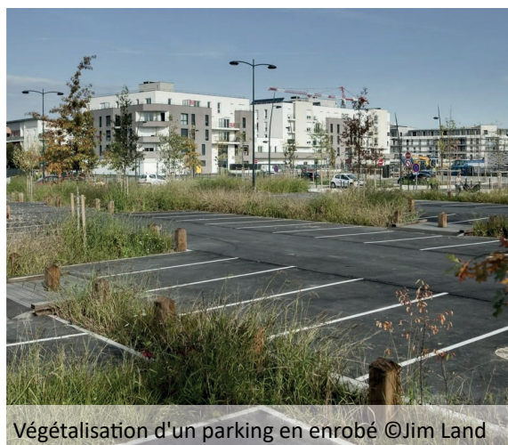
Parking intégrant une trame verte ©CEREMA
